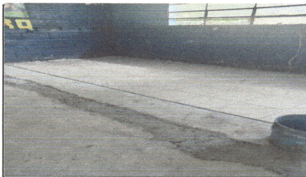
Foto 4: Instalación de piso cerámico
