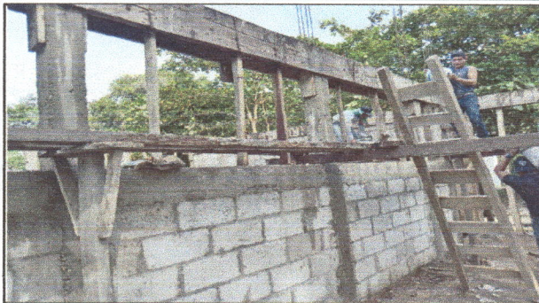
Foto1: Reparación de columnas y paredes
