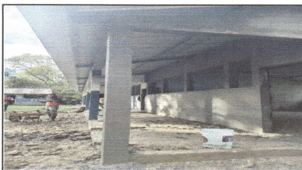
Foto 6: Reparación de pared y columna
