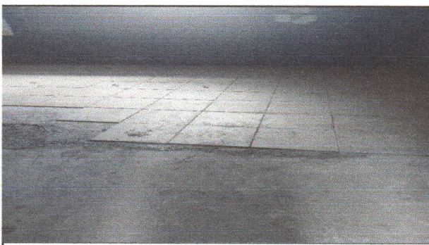
Foto 3: Instalación de piso cerámico
