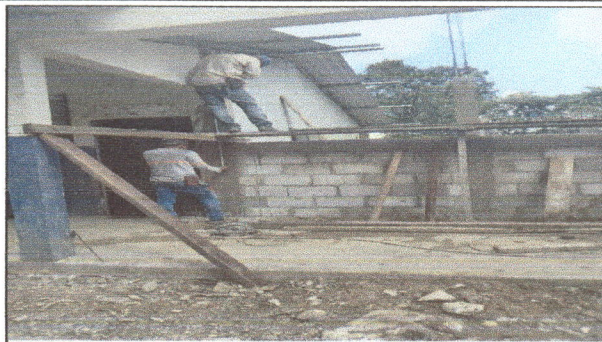
Foto 2: Reparación de columnas y paredes
