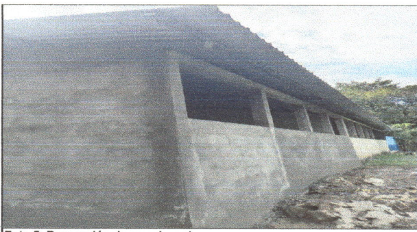
Foto 5: Reparación de pared y columna
